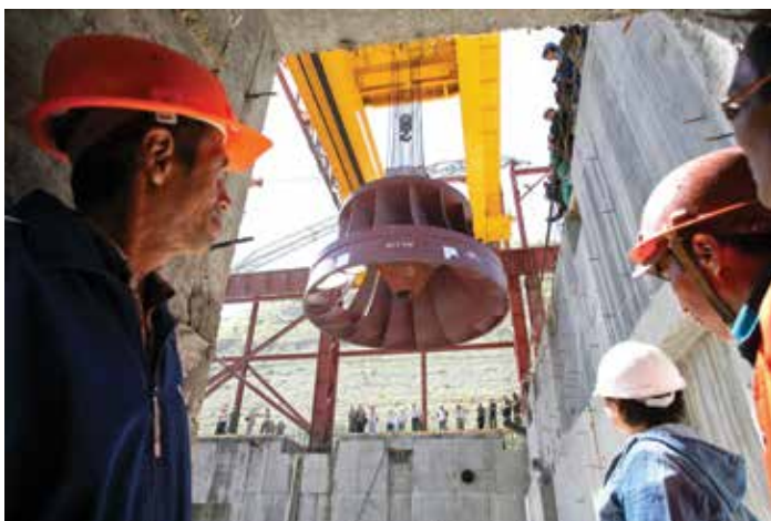
کارگران قرقیز توربینی را در یک فابریکه برق آبی نصب می‌کنند که بخشی از شبکه فابریکه‌های برق است که حفاظت از آنها در کشور تقویت شده است. روتنرز
