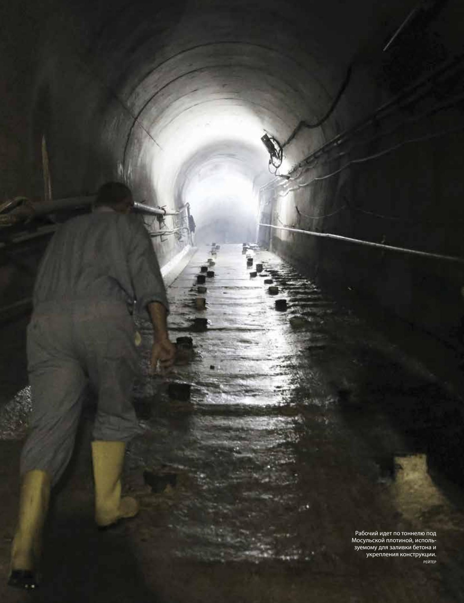
Рабочий идет по тоннелю под Мосульской плотиной, используемому для заливки бетона и укрепления конструкции.
